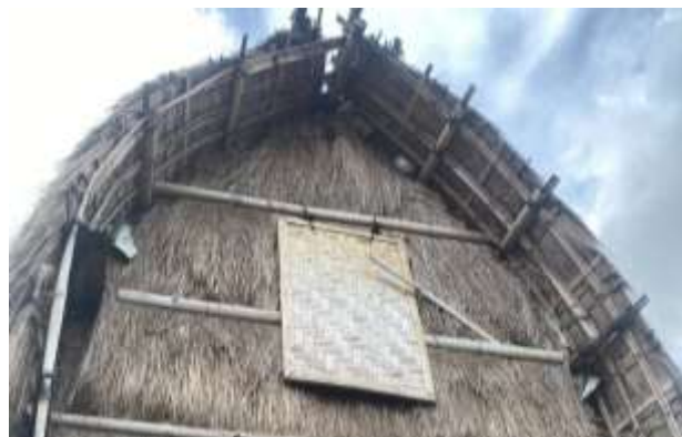
Gambar 2 Struktur bale Sasak dari bawah, memperlihatkan rangka bambu, dinding anyaman, dan lapisan atap alang-alang tebal sebagai konteks pembelajaran material komposit dan insulasi termal.
