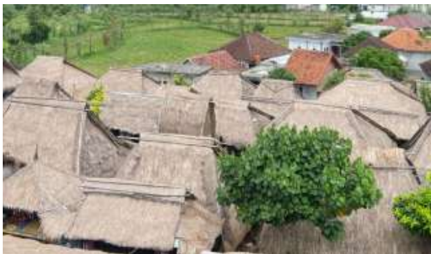
Gambar 1 Panorama atap-atap rumah adat Sasak (bale) di Desa Sade, memperlihatkan penggunaan alang-alang secara menyeluruh sebagai material insulasi termal alami.
